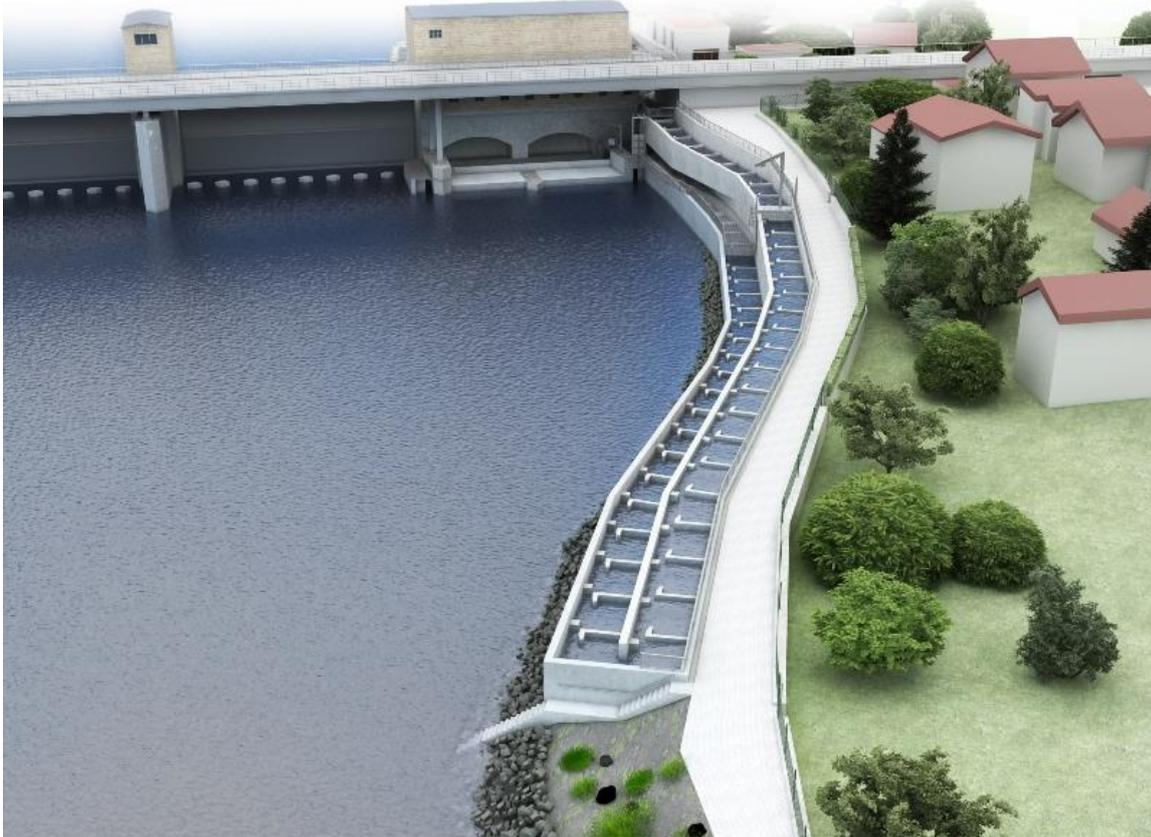
Chema Fischaufstiegsanlage (FAA) an einer Wehranlage mit einem Wasserkraftwerk (Quelle Bundesanstalt für Wasserbau Karlsruhe)
